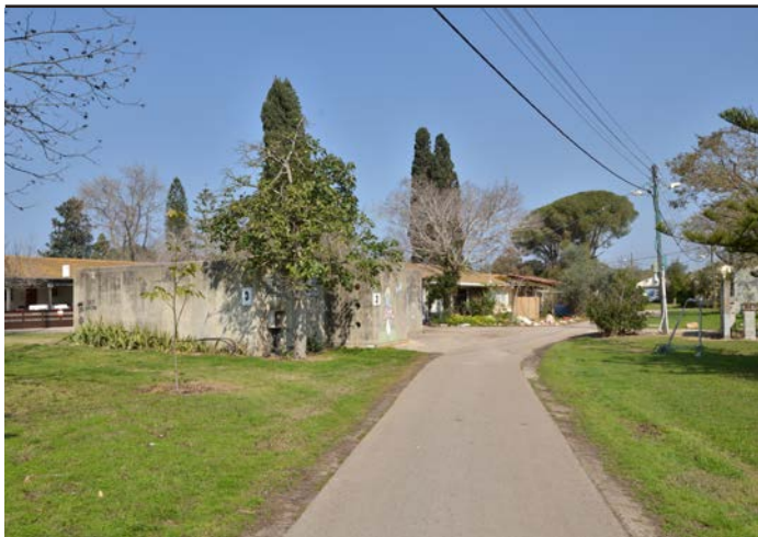
Původní a stále funkční protiraketový kryt
