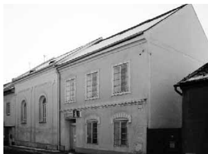
Kdyně – budova synagogy se školou
